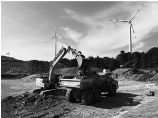
Der Landkreis Miltenberg erweitert derzeit seine Kreismülldeponie um die Bauabschnitte IVa und Va. Im Zuge dieser Bauarbeiten werden u.a. ca. 35.000 m<sup>3</sup> Erdmassen verdrängt und eine Basisabdichtung gebaut, die verhindert, dass Schadstoffe ins Grundwasser gelangen können.
