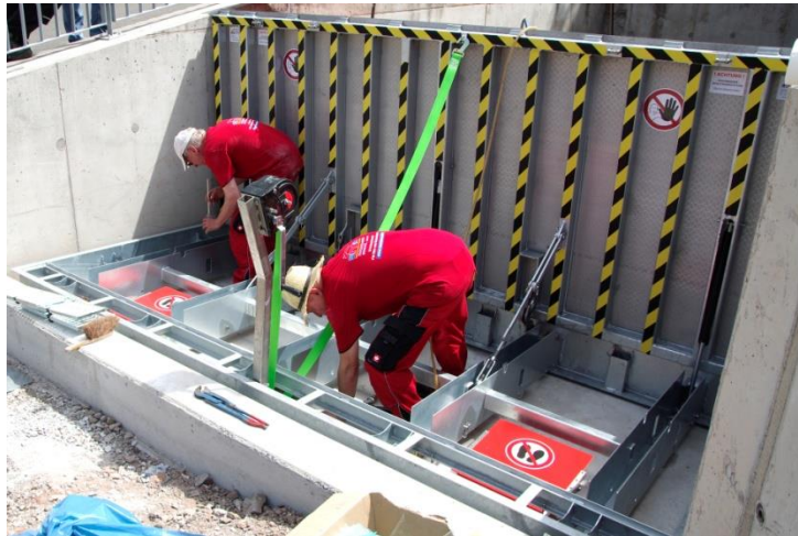
Während der Montage
