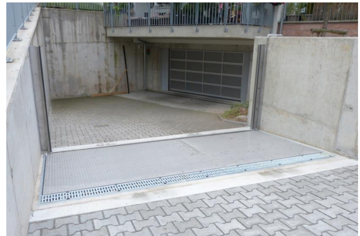
Nach der Montage – einsatzbereit!
