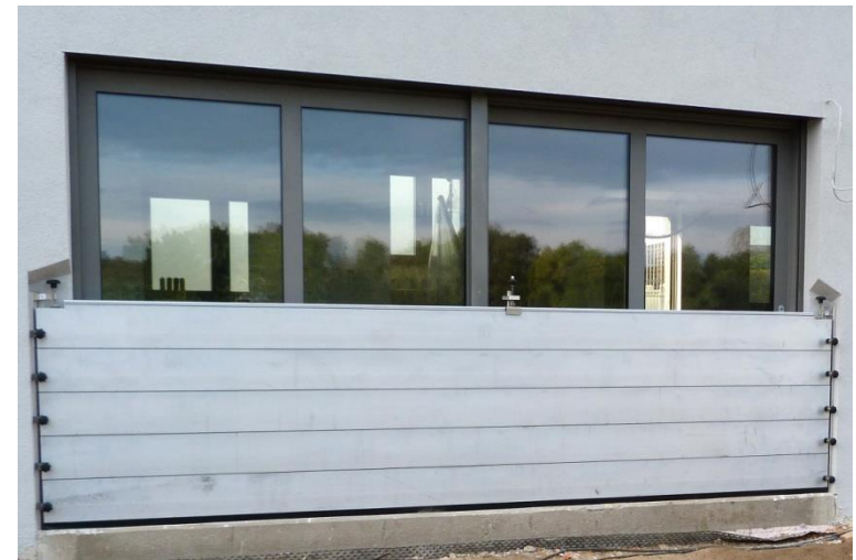
an einem Terrassenelement
